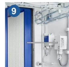
Versátil sistema de sensores (com carta Modbus) para medição de temperatura, humidade, qualidade do ar e pressão diferencial permitindo um controlo total
