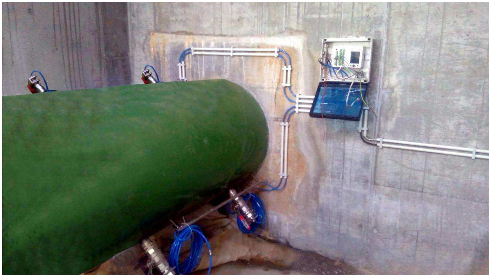
Instalação em conduta DN 1200, com 2 pares de sensores (2 percursos)
