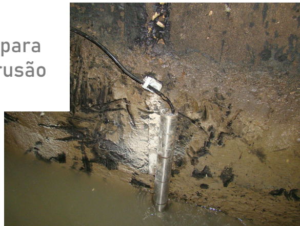
Medição do nível em sumidouros para detecção de inundações
